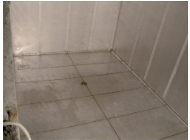
FIG|04| L'interno del serbatoio finito.
