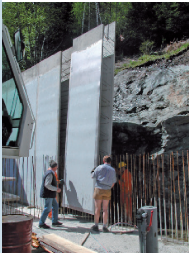
FIG|05 Fasi di posa delle lastre.
