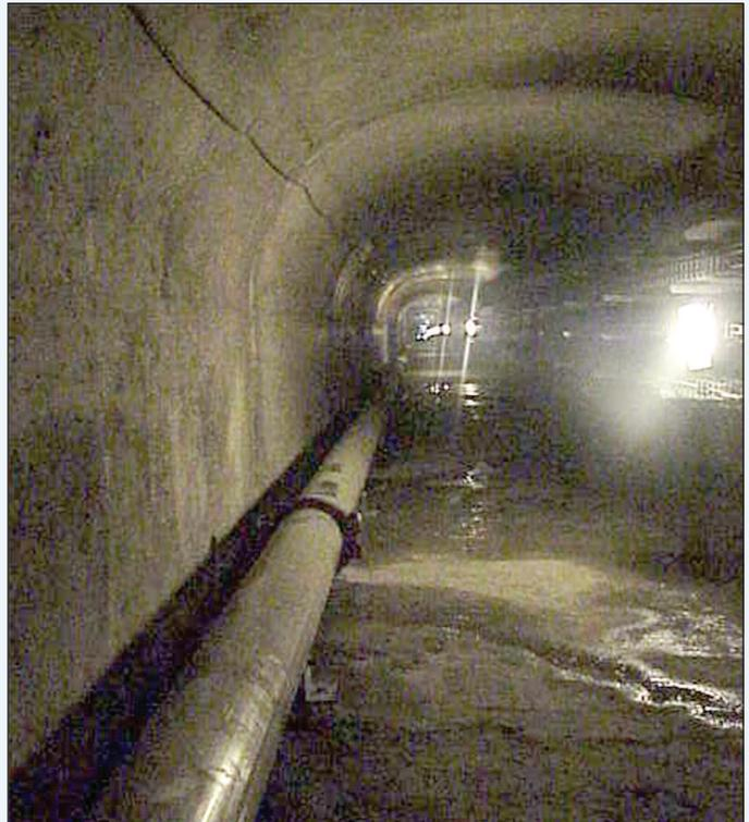
*Una fase dei lavori di ristrutturazione del tunnel del Monte Bianco in cui è visibile la tubazione antincendio, realizzata in acciaio inossidabile EN 1.4404 (AISI 316L)*
