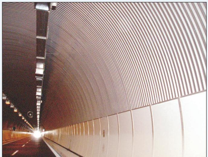
*Il rivestimento della volta di una delle quattro gallerie della tangenziale di Vicenza, ottenuto con lamiera grecata inox EN 1.4301 (AISI 304), precalandrata*
