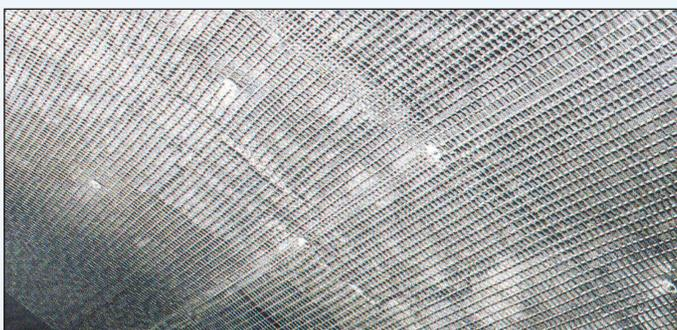
*Le reti composte da barre elettrosaldate inox, grazie alla loro elasticità, si adattano molto facilmente alla curvatura della volta*
