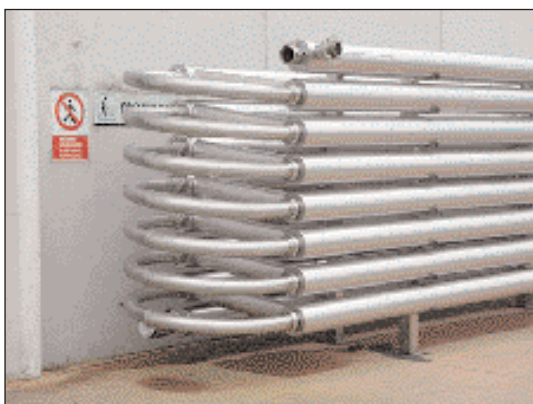
Fig. 3 Scambiatore di calore per pigiato d'uva per l'industria alimentare realizzato in AISI 304. A heat exchanger (material: AISI 304) for grape crush, with applications to the food industry.
