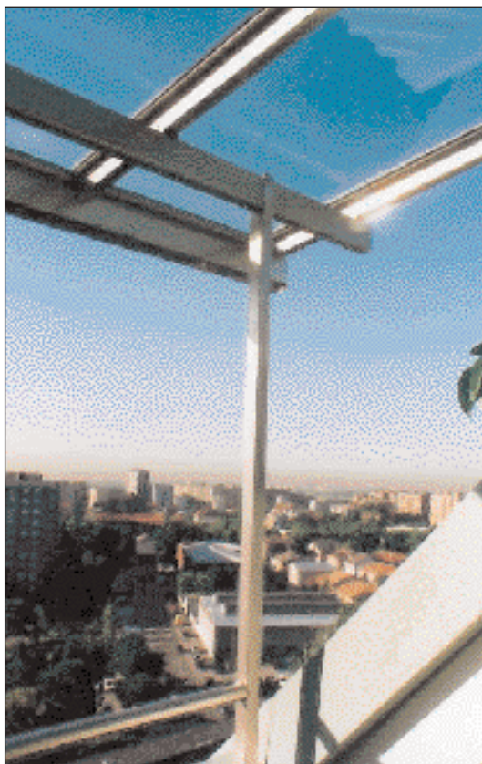
Fig. 14 Tubolare inox tondo e rettangolare impiegato per la costruzione dell'ossatura di strutture di protezione dalle intemperie di terrazzi o mansarde. Round and rectangular shaped, stainless steel rods used for the construction of skeletons of environmental protection structures for terraces and mansard applications.
