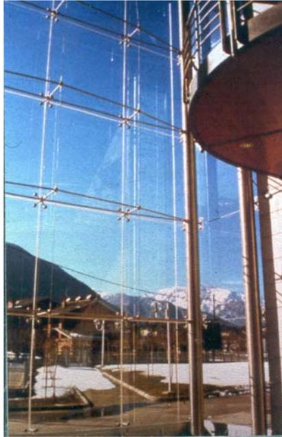
Centrale del latte di Aosta: un esempio di vetrata strutturale con elementi di fissaggio in acciaio inossidabile.
