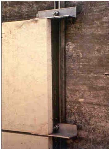
Ancoraggi e profili di sostegno di un tamponamento “a cappotto” eseguito con lastre di marmo.
