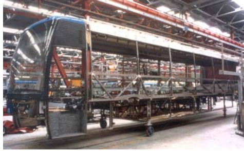
Figura 7: Testata, pianale e traliccio in acciaio inox assemblati.
