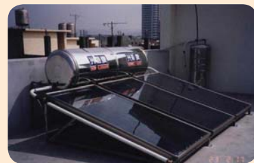
Riscaldatori d'acqua a pannelli solari, Taiwan, Cina.
