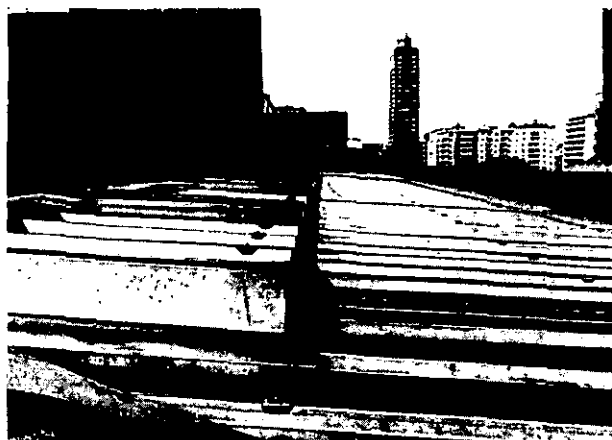
Fig. 16 Tetto del padiglione delle Comunità Europee all'EXPO di Montreal (1966). Esso è realizzato con pannelli prefabbricati costituiti da nastri di acciaio inossidabile austenitico AISI 304 incollati su telai di legno. Le giunzioni tra pannello e pannello sono opportunamente sigillate con materiali adesivi.
