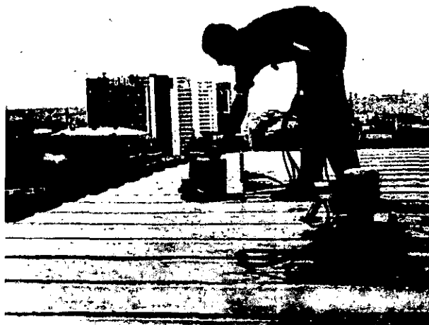
Fig. 11 Tetto di abitazione in Stoccolma realizzato con nastri d'acciaio inossidabile austenitico, uniti per saldatura a resistenza. In primo piano è visibile la saldatrice e in secondo la bordatrice.
