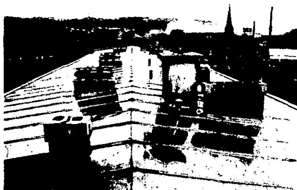
Fig. 2 Tetto di edificio scolastico a Petit Quevilly (Francia, dip. Seine Maritime) realizzato con nastri aggraffati d'acciaio inossidabile ferritico tipo AISI 430 di 4 m di lunghezza e 800 mm di larghezza. La pendenza è del 15%. Notare la presenza di camini di riscaldamento.
