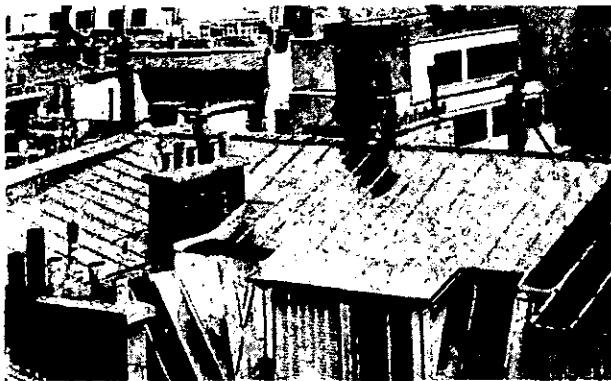
Fig. 3 Tetto di un edificio d'abitazione a Parigi, in rue Pierre Charron (8 a arr.). Si tratta di un rifacimento con nastri di acciaio inossidabile ferritico del tipo AISI 430, d'una copertura di circa 90 m 2 esposta ai fumi di nafta. Note le condizioni dei tetti vicini non d'acciaio inossidabile.
